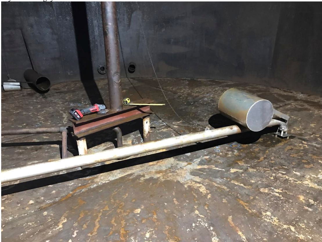
Mynd 2. Geymir er ómálaður innanvert að þaki undanskyldu.
