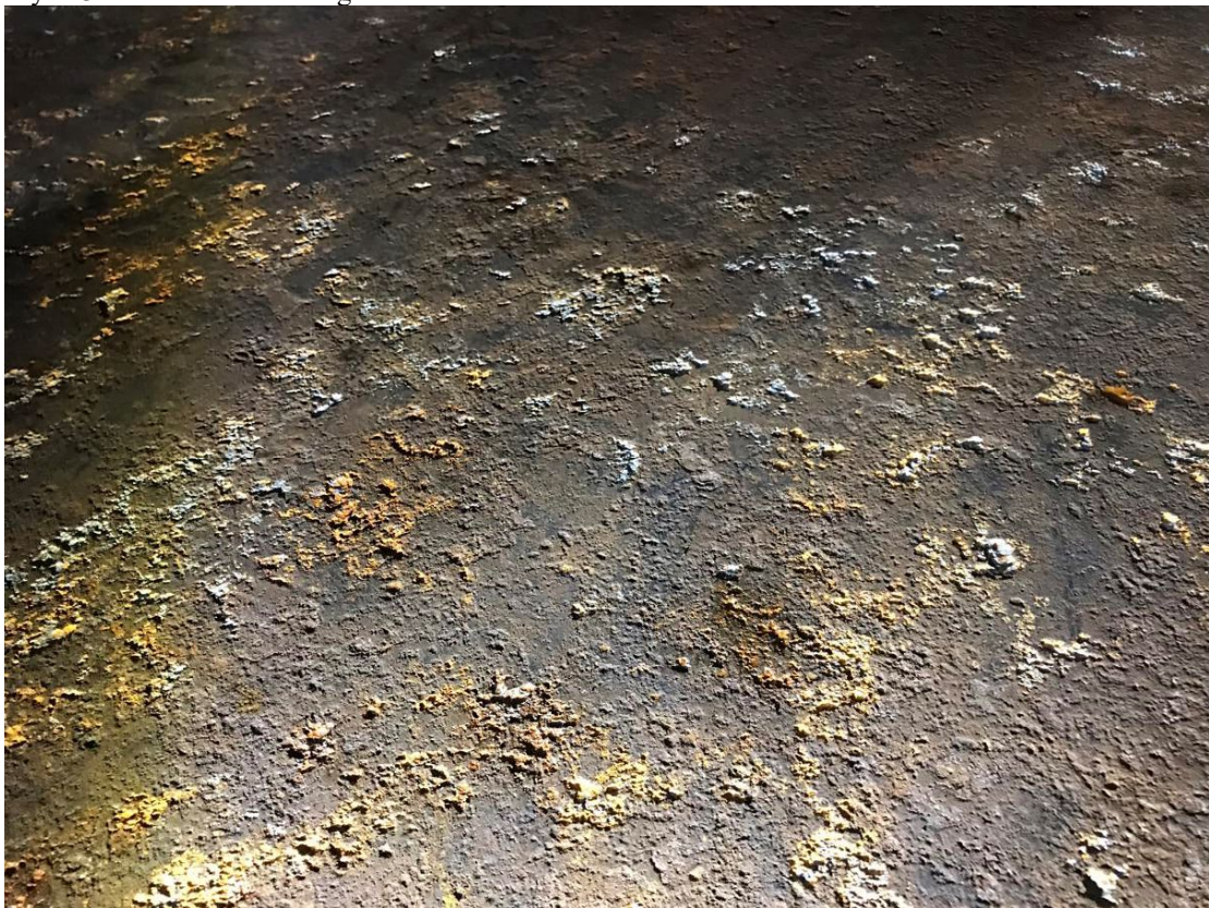
Mynd 4. Lítt tæring er á öllu gólfinu og víða eru 2 – 3 mm djúpir pyttir og einstaka pyttir sem ná 4mm dýpt.
