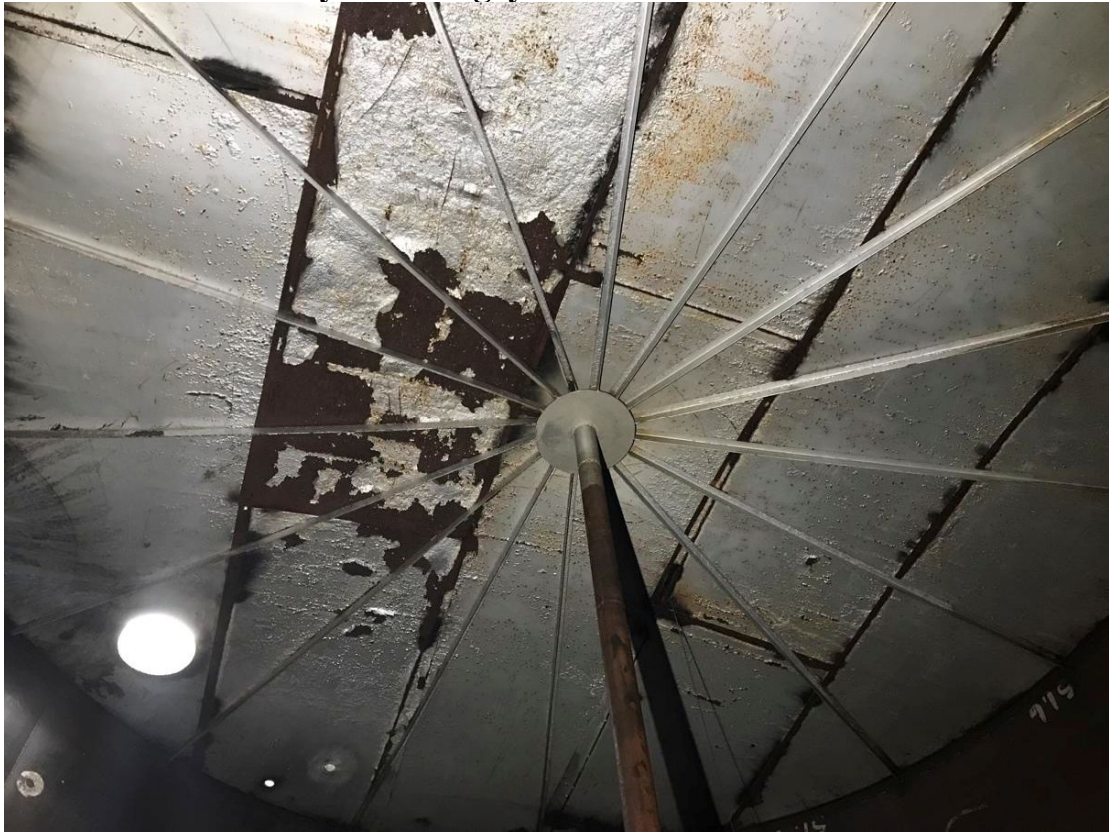
Mynd 1. Þak geymis
