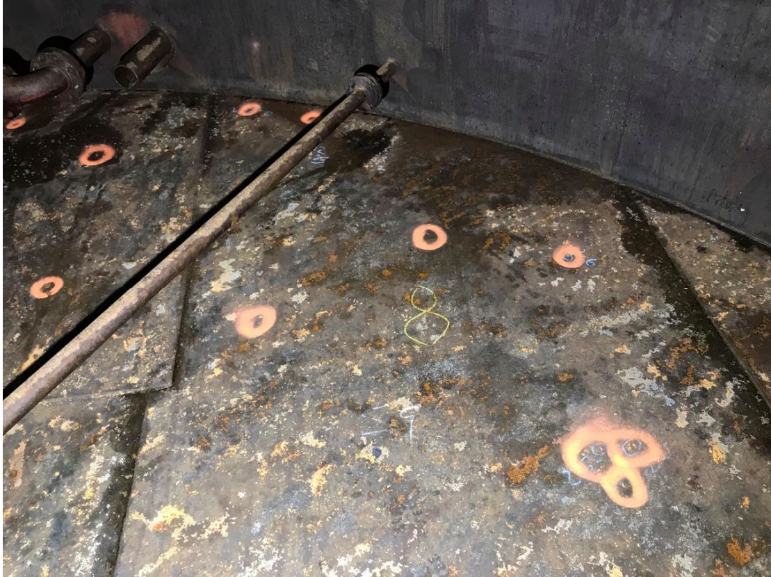
Mynd 7. Farið var um gólf og allir pyttir merktir upp sem voru dýpri en 2,6mm
