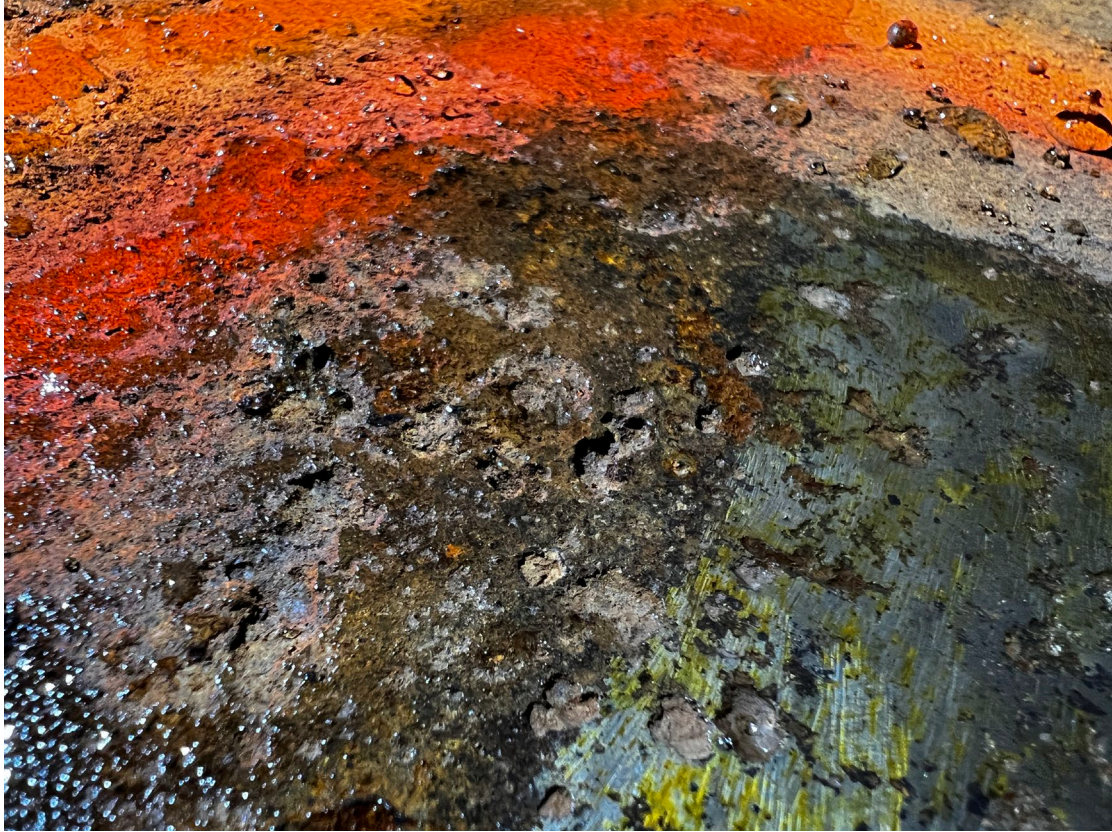
Mynd 10. Geymir er pyttaður víða um geymirinn. Slípað var í nokkra og mældist efnisþykkt um 5mm.
