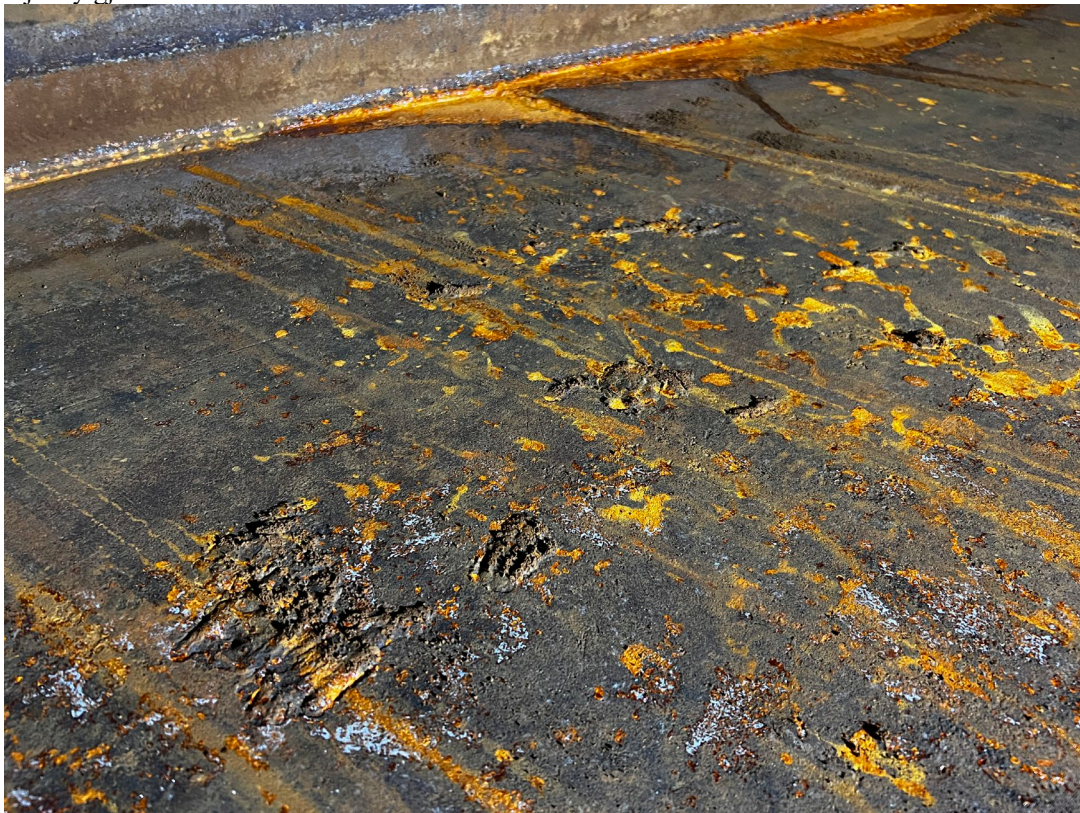
Mynd 9. Víða eru gamlar viðgerðir sem gera geymirinn erfiðan til skönnunar.
