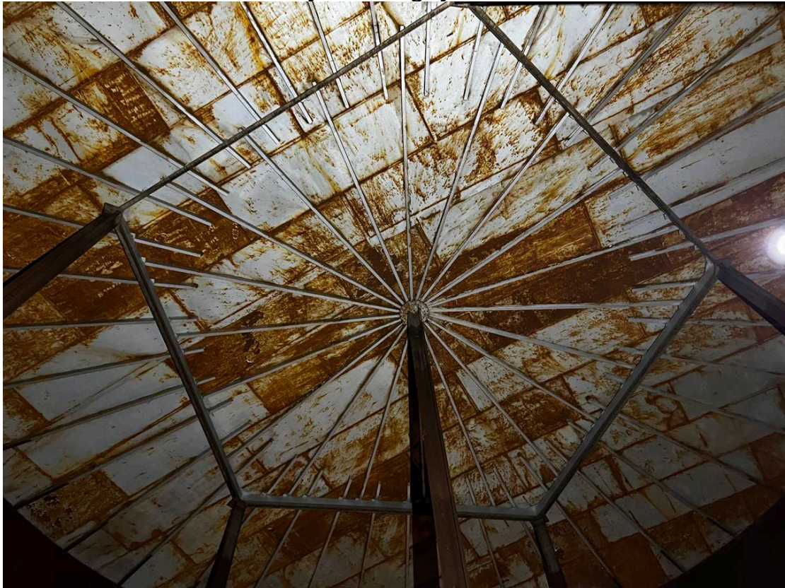
Mynd 1. Þak geymis.
