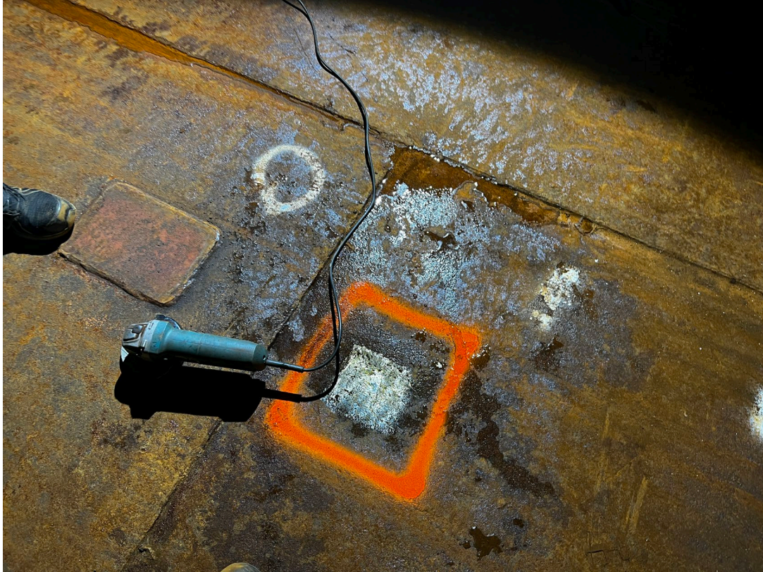
Mynd 8. Öll tæringarsvæði sem fundust með segulsviðsskanna voru slípuð hrein og síðan mæld með hljóðbylgjuskanna.
