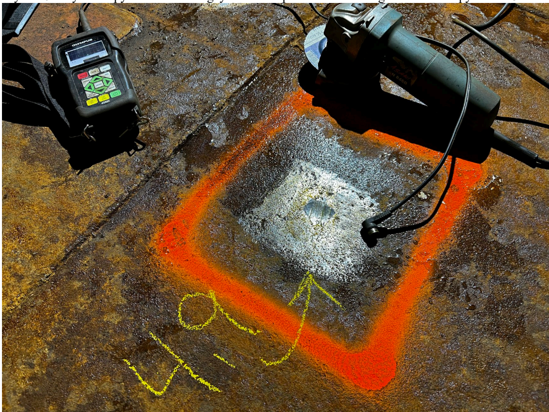
Mynd 11. Geymir er pyttaður víða um geymirinn. Slípað var í nokkra og mældist efnisþykkt um 5mm.
