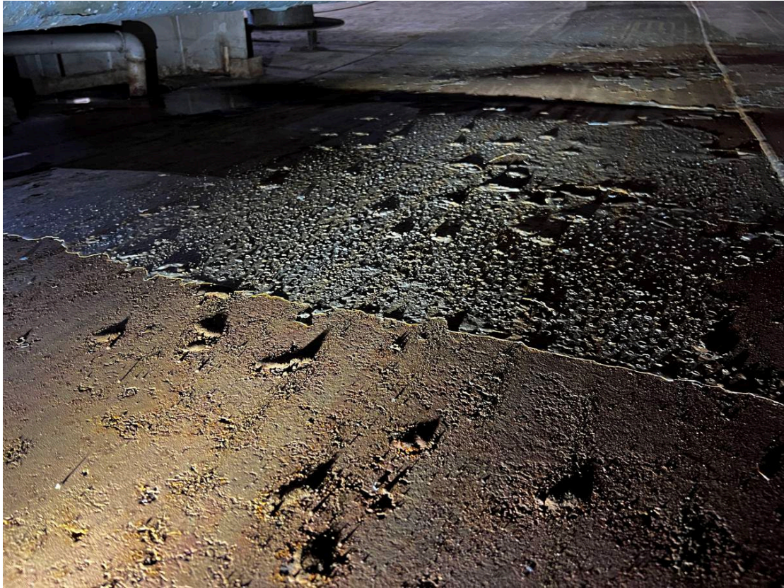
Mynd 3. Við miðjan geymi er búið að sjóða fjöldan allan af suðustrengjum.
