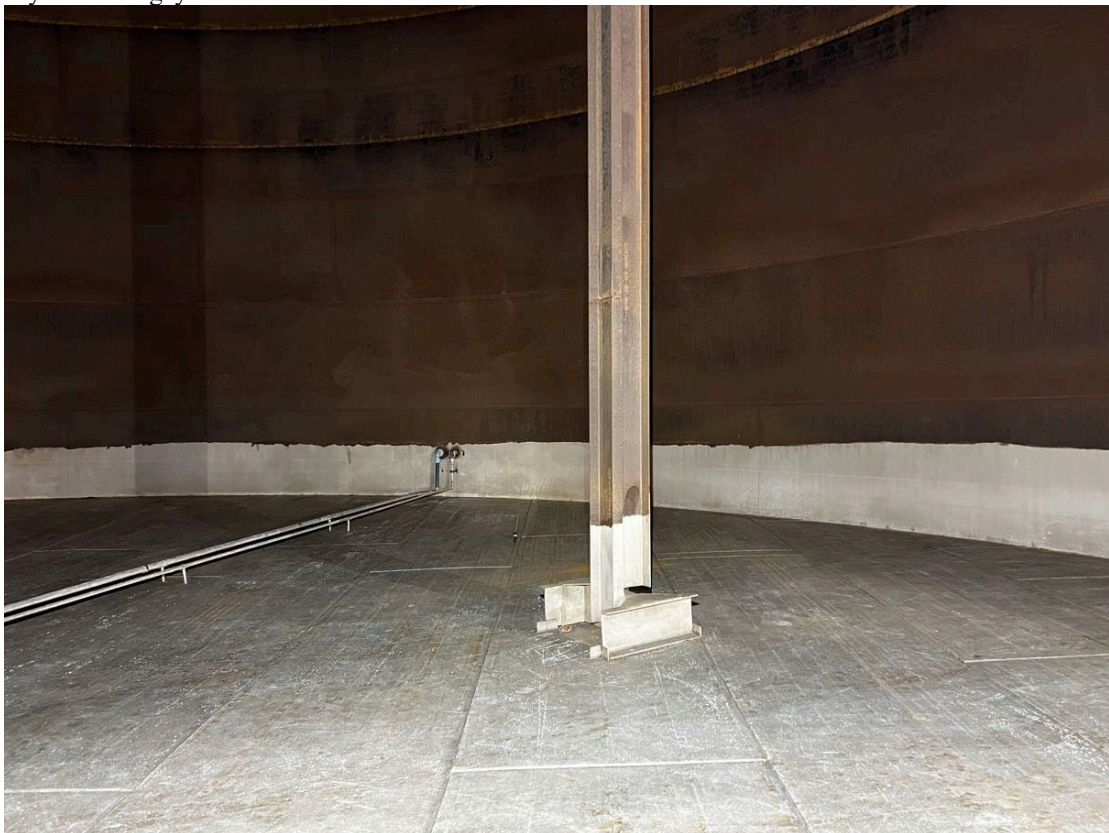
Mynd 2. Gólf og umfar geymis.
