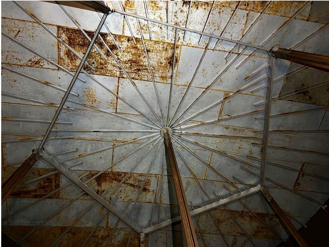
Mynd 1: Þak geymis.
