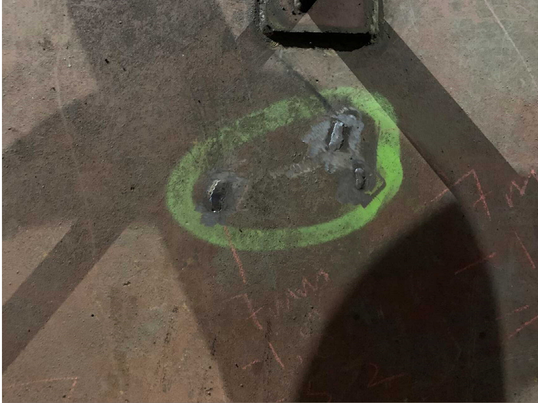
Mynd 4. Soðið var í pytti. Um 3 mm voru eftir af efnisþykkt plötu.
