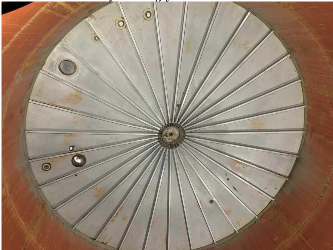
Mynd 1. Þak geymis.
