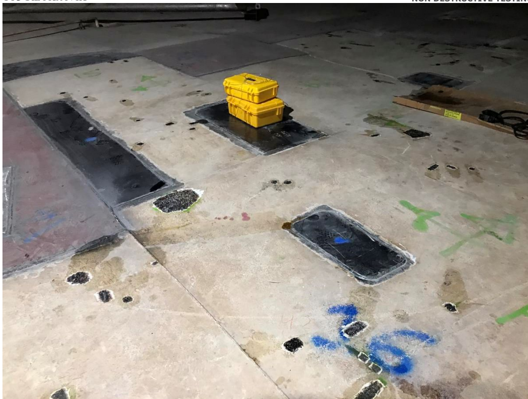
Mynd 2. Víða fundust ummerki tæringar og voru þær allar ( 174 ) merktar inná gólf og sannreynðar með þykktarmæli. Aðeins á tveimur stöðum er efnisþykktin minni en 3mm
