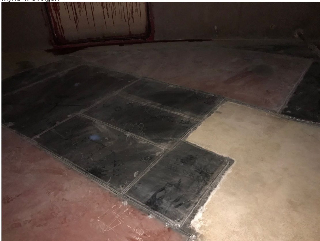
Mynd 5. Bætt var við tvöföldunarplötum frá tillögu síðustu mælingar 2018. Merkt inná teikn.
