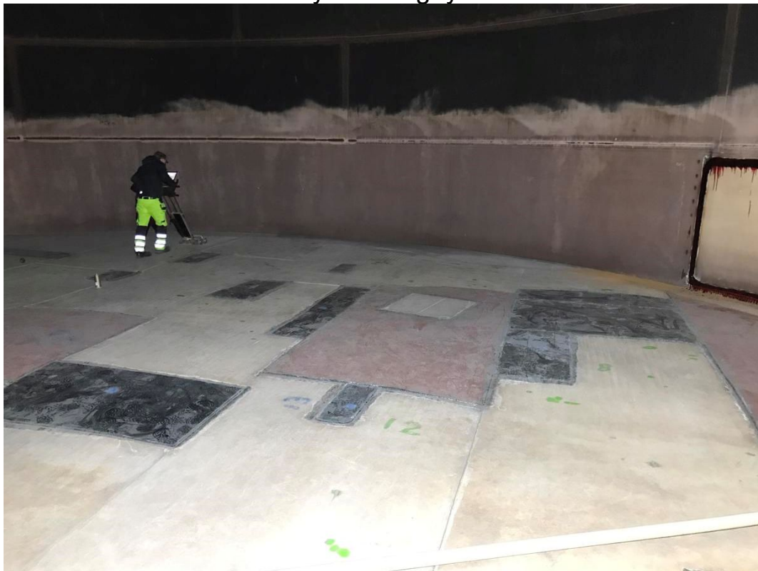
Mynd 1. Búið er að tvöfalda botn víða eftir mælingu 2018. Bætt var við plötum eftir aukamælingu 2020. Framkvæmt af Stálsmiðjunni Hamar á Akureyri
