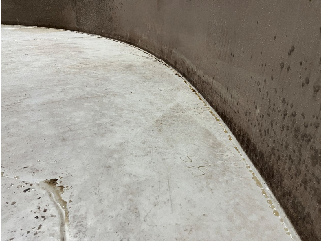
Mynd 5. Kverk innvert í geymi lítur vel út.
