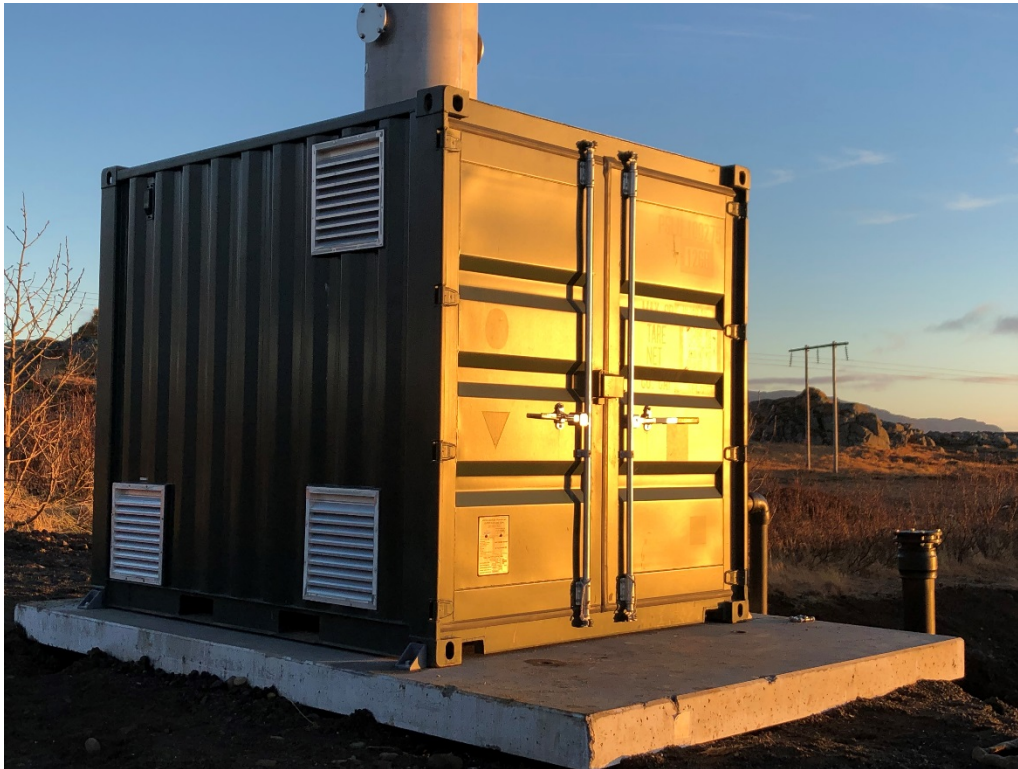
Mynd 6. Kyndill kominn á steypa plötu og þar með framtíðarstað
