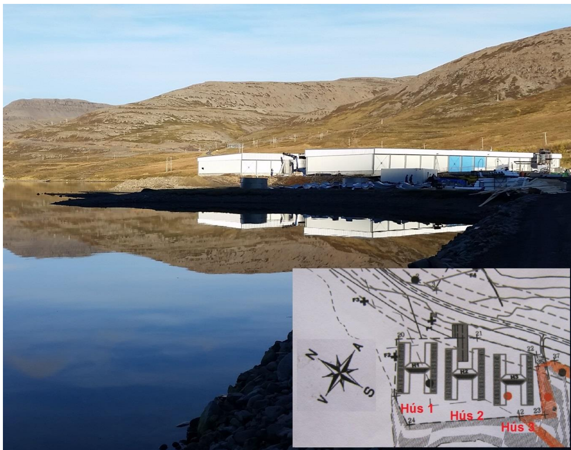
Mynd 4-1 Seiðaeldisstöð fyrirtækisins Arctic Smolt ehf. í byggingu í Tálknafirði. Seiðastöðin samanstendur af þremur húsum sem hvert um sig er 3.000 m 2 og kerjarými innanhús verður samtals 8.400 m 3 . Lokið er að mestu byggingu á einu kerjahúsi (hús 1) og annað hús er langt komið (hús 3). Myndin sýnir fyrsta húsið sem þegar er komið í notkun og Hús 3 er að hluta komið í notkun. Innfella mynd sýnir staðsetningu eldisstöðvarinnar, neðan þjóðvegur í botni Tálknafjarðar.
