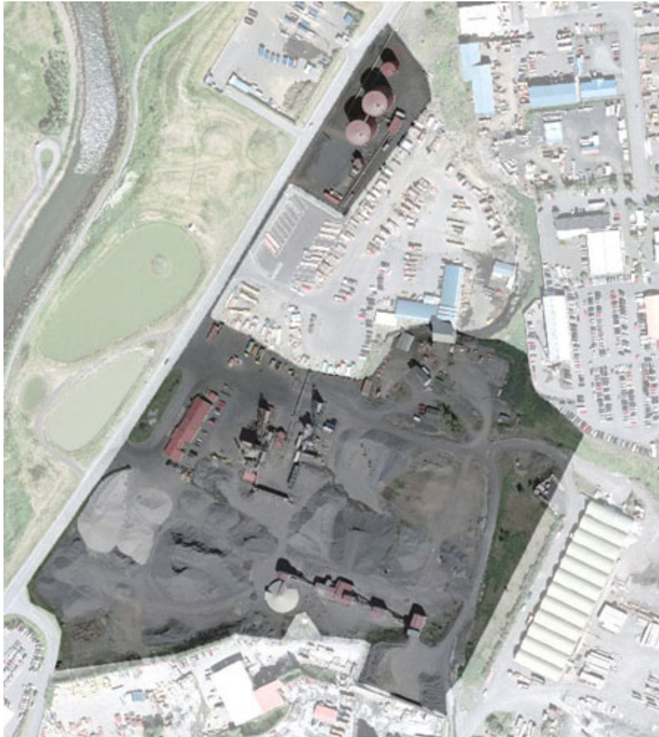
Mynd 1. Yfirlitsmynd af athafnasvæði fyrirtækisins við Sævarhöfða 6-10.
