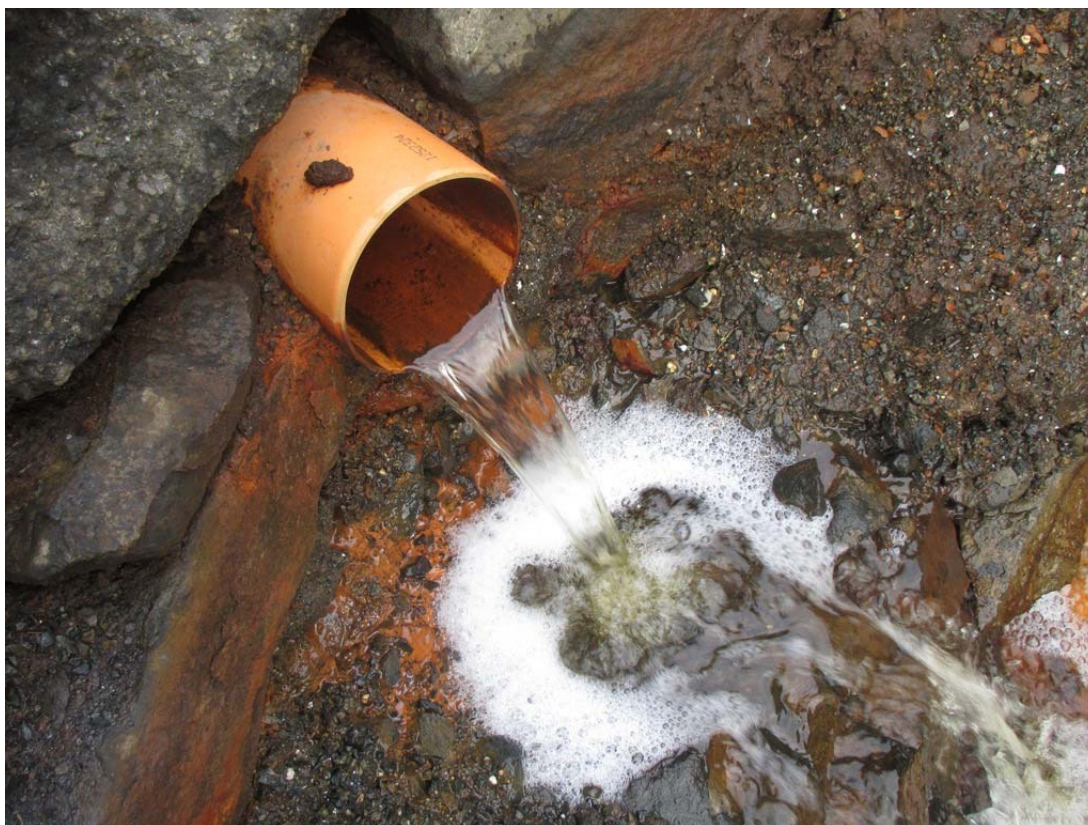
Mynd 9. Útrás frá hreinsikerfinu í Fíflholtum eftir endurbætur. Vatnið í útrásinni var tiltölulega tært og lítil froðumyndun. (Ljósm. S.G. 16. október 2017).
