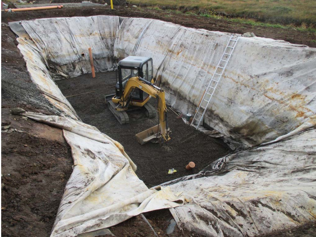
Mynd 2. Unnið að endurnýjun síðubeðsins. Myndin er tekin til norðurs. (Ljósm. S.G. 29. ágúst 2017).
