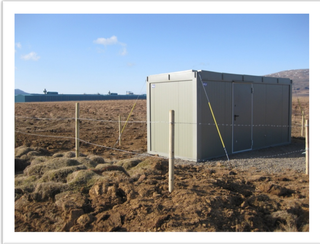
Mynd 1. Loftgæða og veðurmælingahús við Kríuvörðu.
